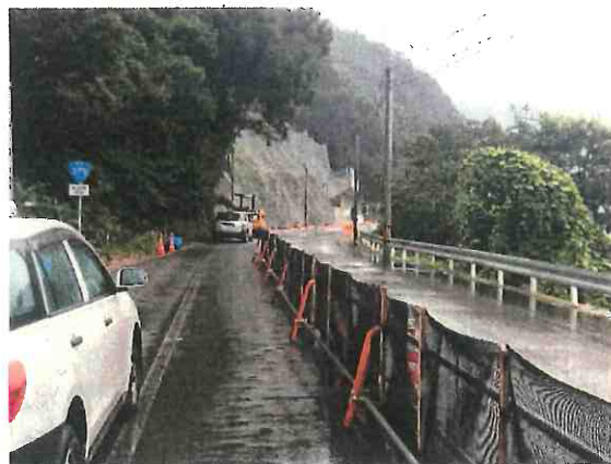
対策状況(ロックシェッド(写真奥))
